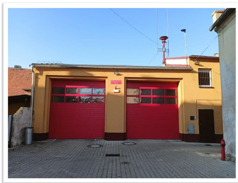
Rysunek 18 Budynek Ochotniczej Straży Pożarnej zlokalizowany w podobszarze rewitalizacji 1 (Wąsosz Południe).
