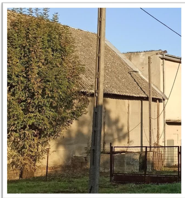
Rysunek 10 Przykłady budynków pokrytych azbestem na podobszarze rewitalizacji 2 (Jednostka 1)
