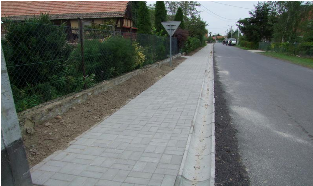
Zdj. Nr 4 – Inwestycja – budowa chodnika w m. Czarnoborsko (źródło UM Wąsosza)
