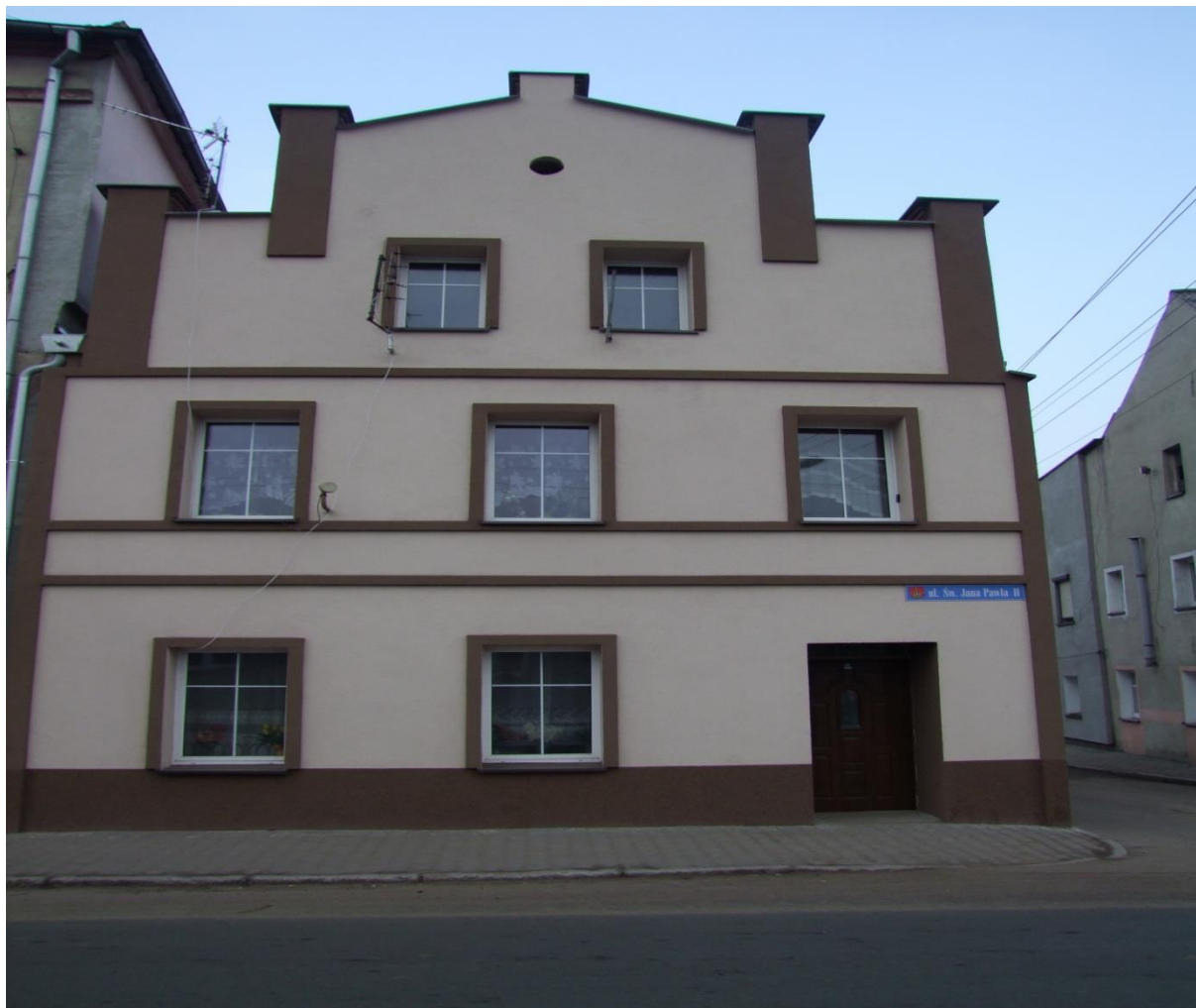
Zdj. Nr 5 – Inwestycja – renowacja kamienic na terenie Wąsosza (źródło UM Wąsosza).
