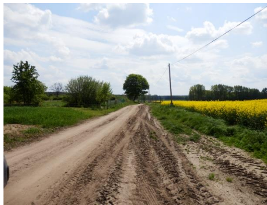
Fot. 16. Droga transportu rolnego – obręb Bełcz Górny
