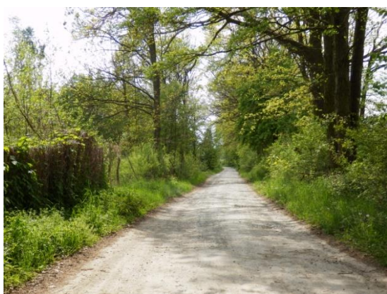
Fot. 17. Droga o nawierzchni tłuczniowej – obręb Cieszkowice
