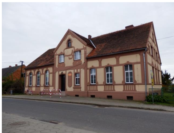
Fot. 20. Świetlica wiejska - obręb Lubiel
