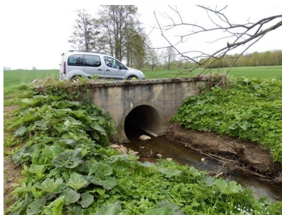
Fot. 24. Przepust na cieku Młyniec – obręb Drozdowice Wielkie
