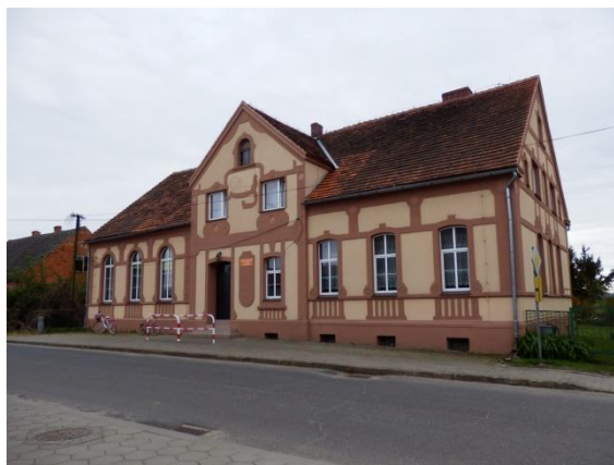
Fot. 20. Świetlica wiejska - obręb Lubiel
