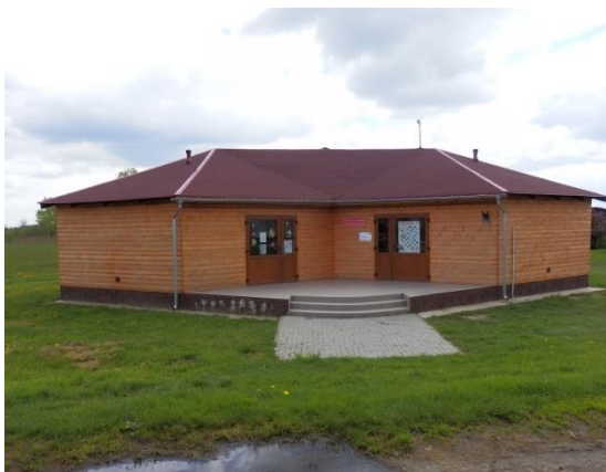
Fot. 19. Świetlica wiejska - obręb Kamień Górski
