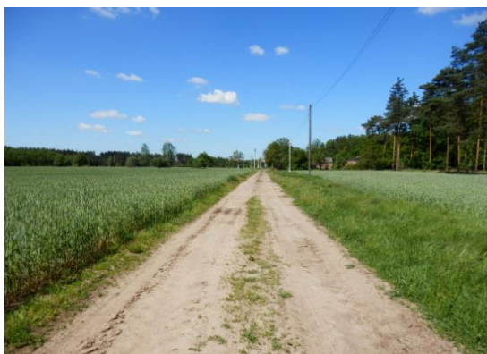
Fot. 27. Droga wskazana do przebudowy – obręb Bartków
